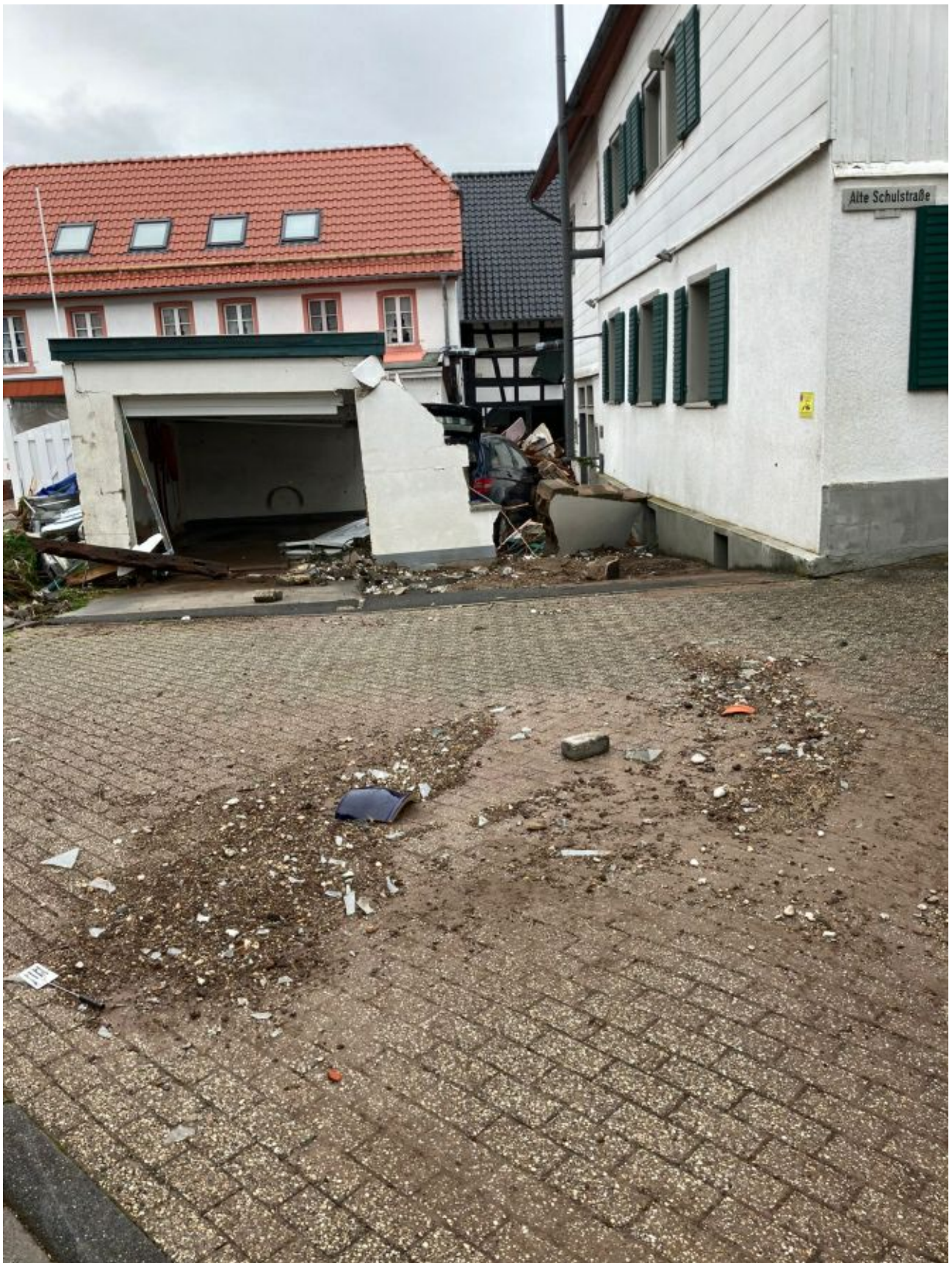
Hochwasserschaden im Juli 2021
